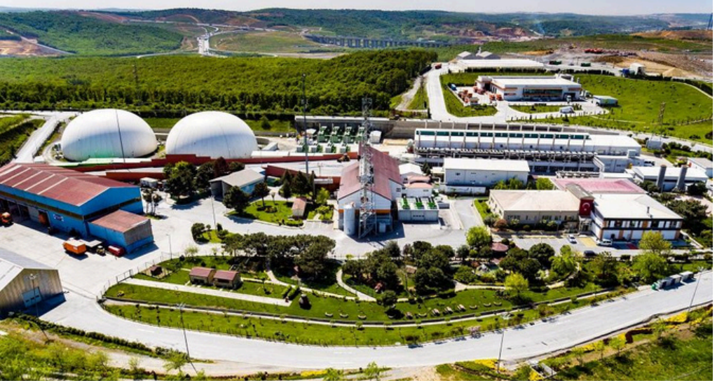
İstaç düzenli depolama tesisi http://3d.istac.istanbul/odayeri-duzenli-depolama-tesisi
